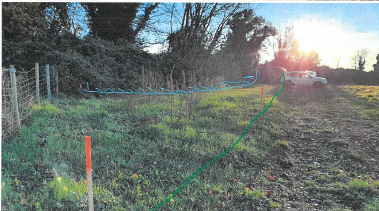
La délimitation de l'agrandissement de la mare se matérialise par la présence de piquets à 2 traits oranges (couleur bleue) et la clôture par la présence des piquets à un trait orange continu (couleur verte).
